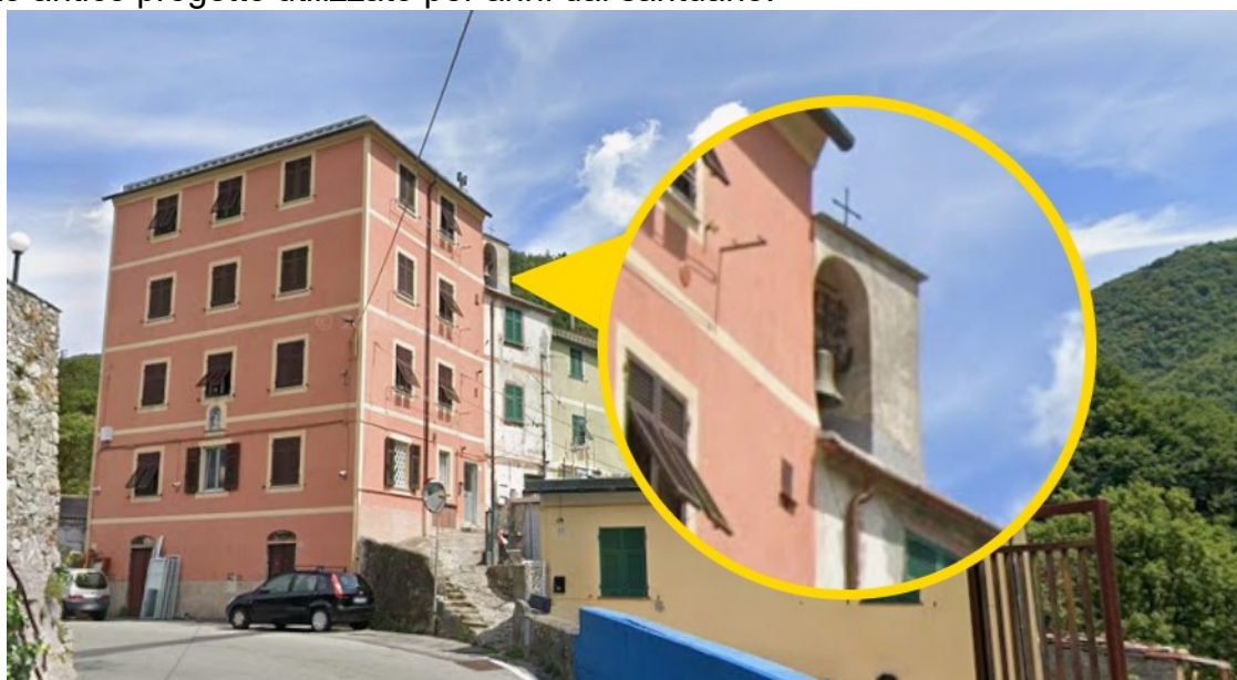
Il ripetitore installato sul palazzo di Via Nasche (Google Maps)
